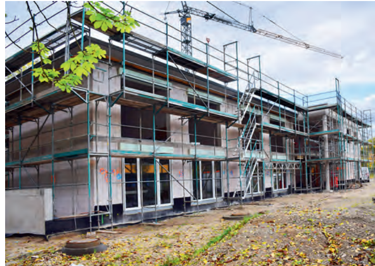
STEIN AUF STEIN: Das Wohnheim in der Braillestrasse nimmt Gestalt an.
